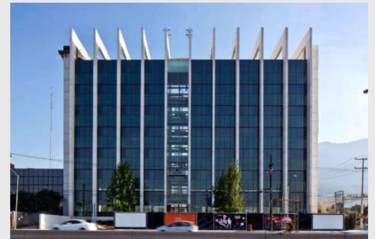
TORRE VASCONCELOS – SAN PEDRO G.G., N.L.
