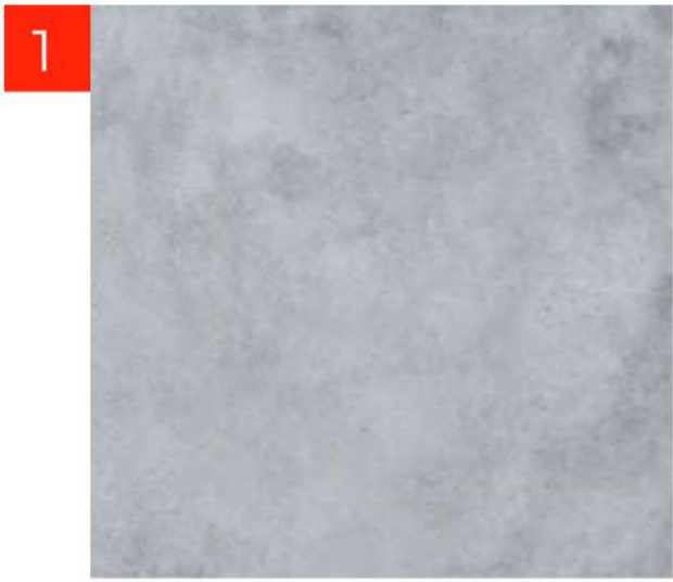
Dos capas: Rich y emparche con Pasta de kimplaster tipo concreto aparente kp-42 marca: kimikolor
