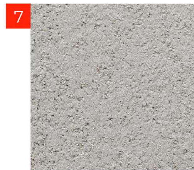
Firme de concreto, acabado blanco lavado fino y sellado
