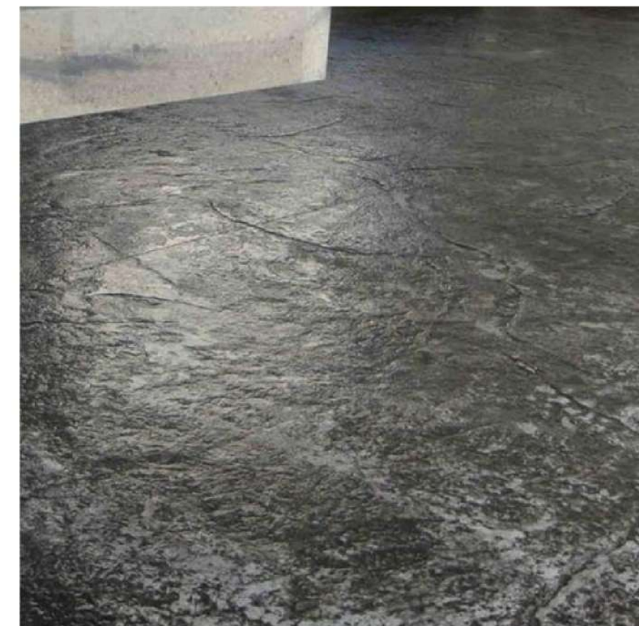
Concreto estampado modelo laja natural, color y endurecedor silver gray y desmoldante dark gray.
